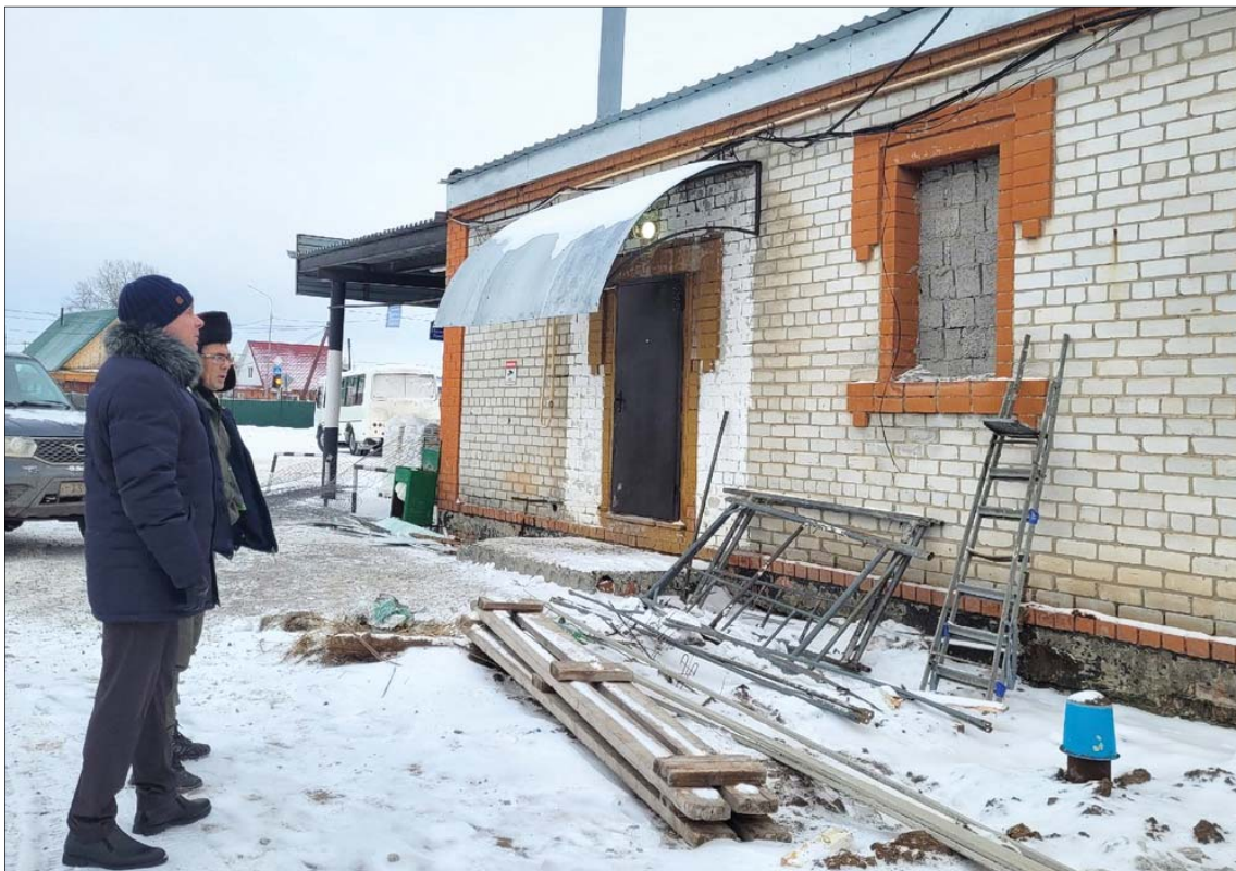
• Александр Григорьев рассказал главе района Игорю Власову, что сейчас на объекте ведётся заливка полов, укладка плитки, штукатурка и покраска стен.
