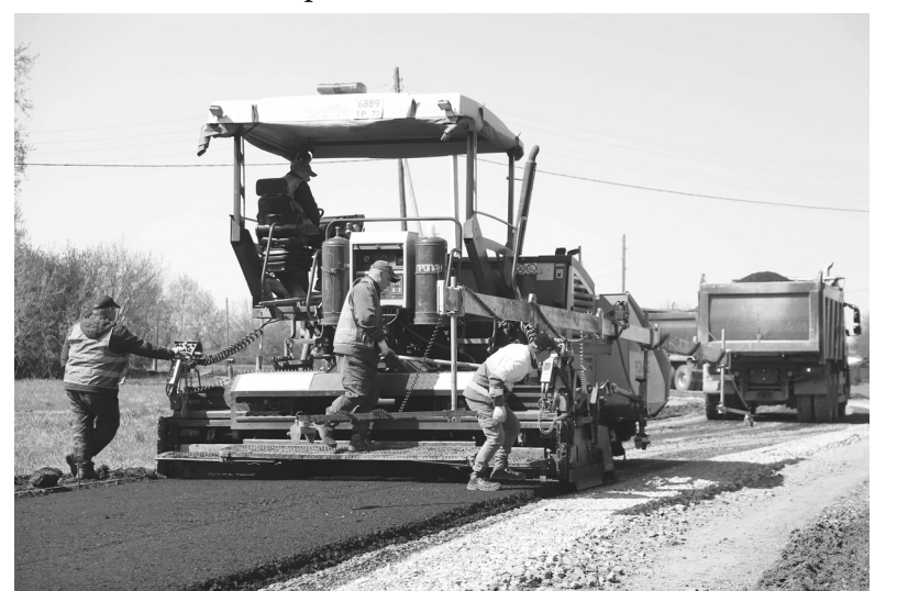
Момент ремонта дороги, проходящей через село Усть-Ламенка, работниками ДРСУ-4
