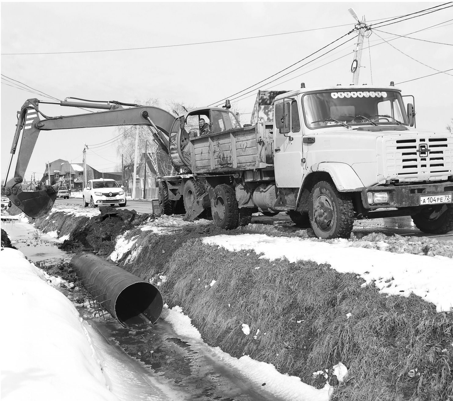
Устранение затора в кювете на улице Вокзальной. Помехой оказался обрушившийся деревянный мостик. Его снесли и уложили большую водопропускную трубу для увеличения проходимости воды по одной из крупных магистралей отвода воды из посёлка Голышманово
