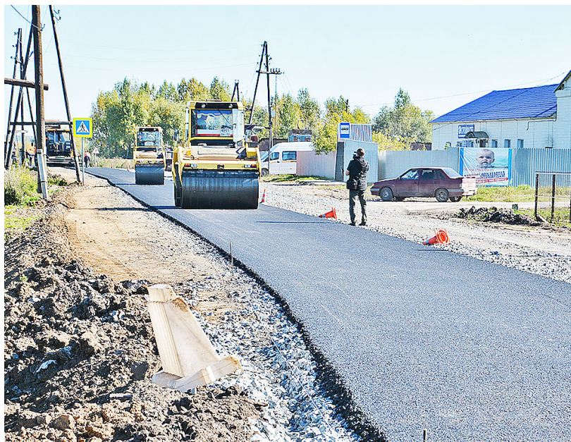
Асфальтирование дороги в Казанском. Протяжённость нового покрытия составляет полтора километра
