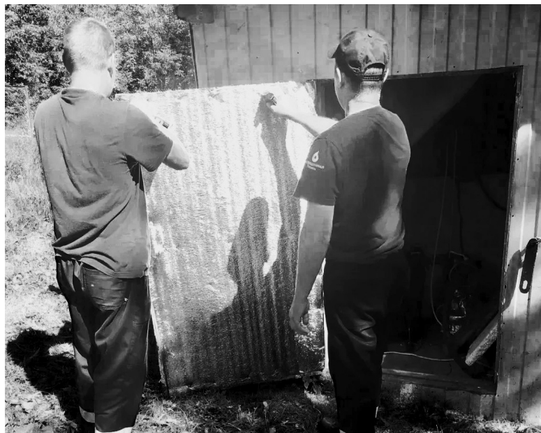
Коммунальщики обследуют водозаборную скважину, прежде чем приступить к утеплению
