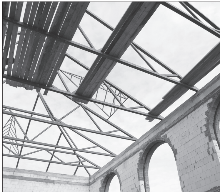
Стропила над спортивным залом будут металлическими
