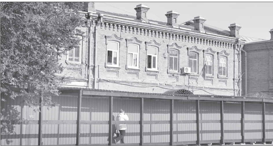
Масштабные ремонтно-реставрационные работы развернулись на площадках в границах одного перекрёстка /ФОТО АЛЕКСАНДРА СМЕРНОВА
