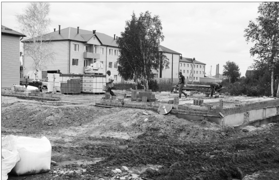
В микрорайоне по улице Комсомольской ООО «Сибстрой» продолжает строительство жилья
