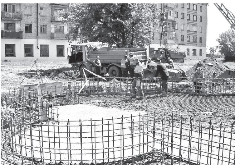
• Лето 2005 года. Строительство фонтана и обустройство центральной площади Заводоуковска завершилось в короткие сроки.
