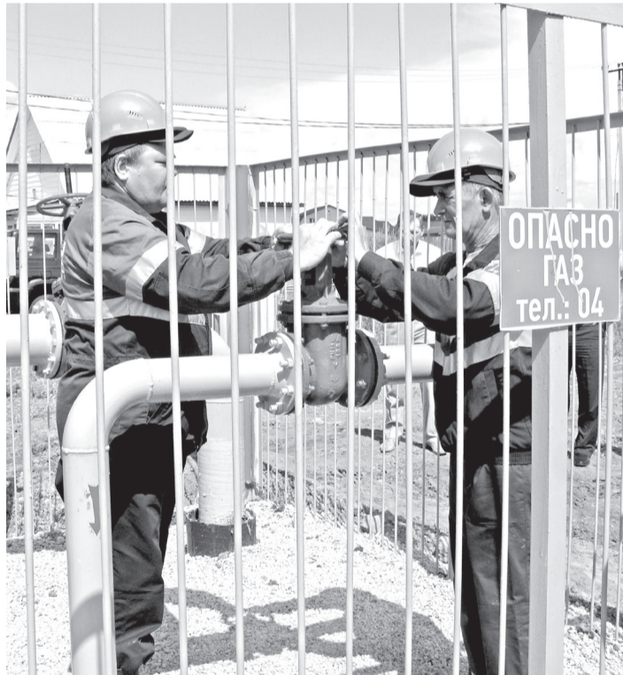
• Июнь 2015 года. Заводоуковск, микрорайон Новый. Долгожданный запуск газа.
