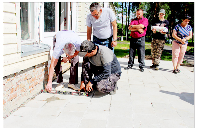
• Глава округа Игорь Власов проверяет при помощи строительного уровня уклон нового крыльца у Дома культуры в Кармацкой.
