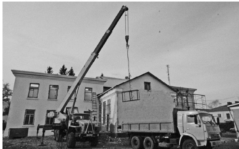
► Ремонтные работы в ДДТ // Фото из архива Татьяны СУХОВОЙ
