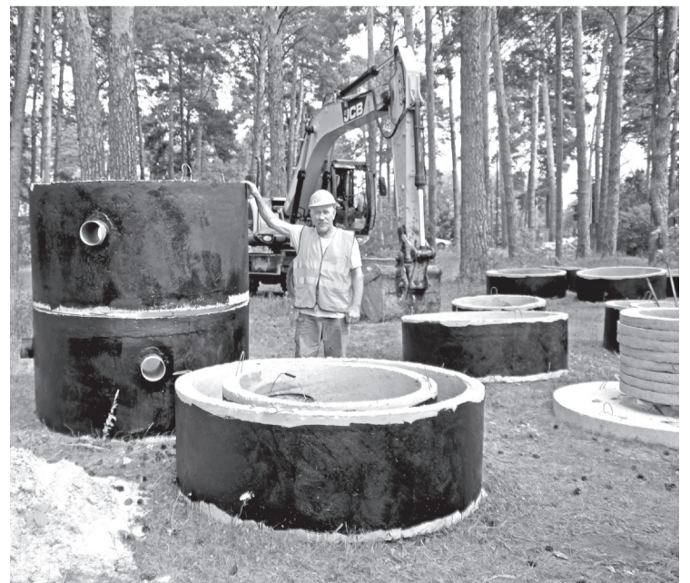
• На улице Парковой будет смонтировано около трёх десятков колодцев из железобетонных колец.
