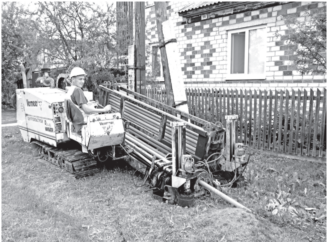
• Трубопровод на улице Парковой в городе специалисты прокладывают с помощью установки горизонтально-направленного бурения.
