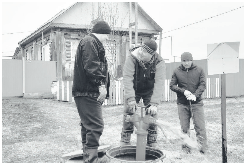
Проверка работы противопожарного гидранта.
