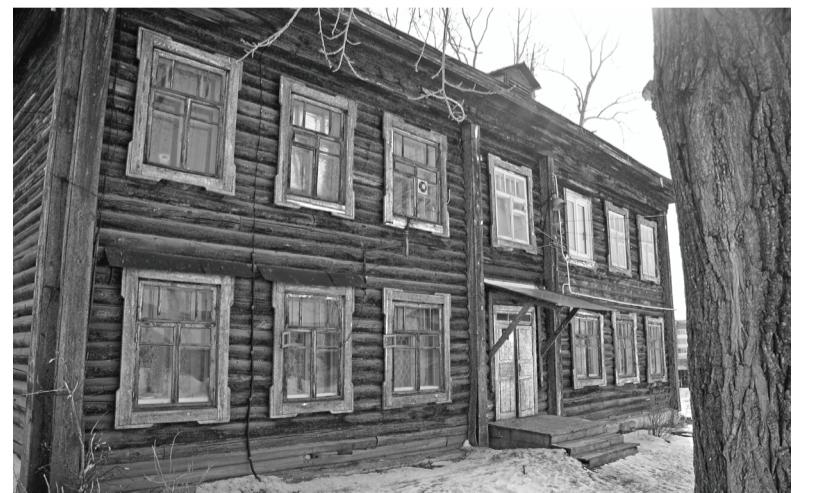
Дворовый фасад дома на ул. М. Садовая, 1/37. 2012 год. // Фото Геннадия КРАМОРА.
