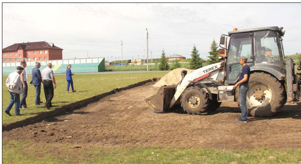
• Так начинались работы по строительству площадки для подготовки и сдачи норм ГТО.
