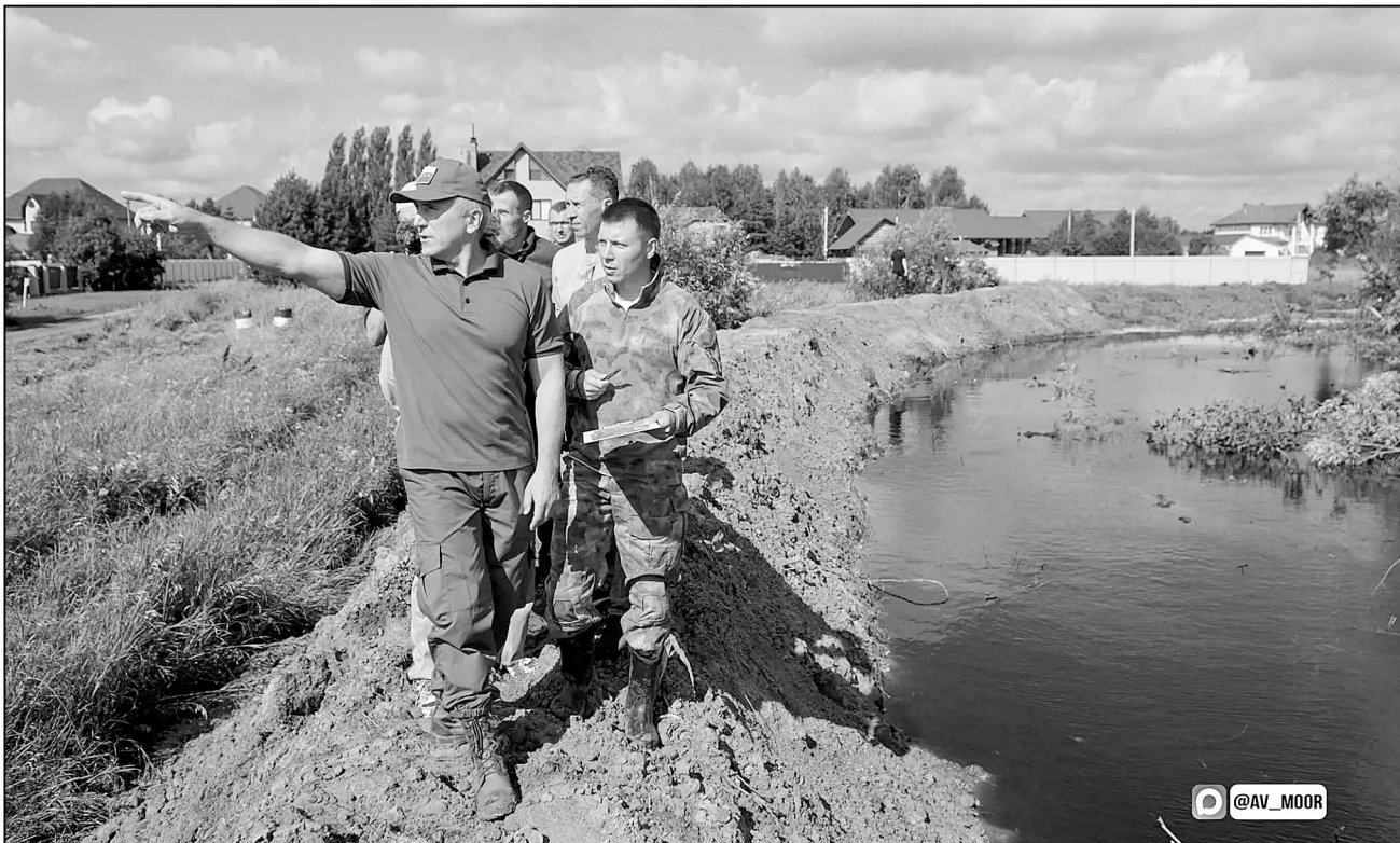
Губернатор Александр Моор проинспектировал противопаводковые работы в Тюменском округе.
