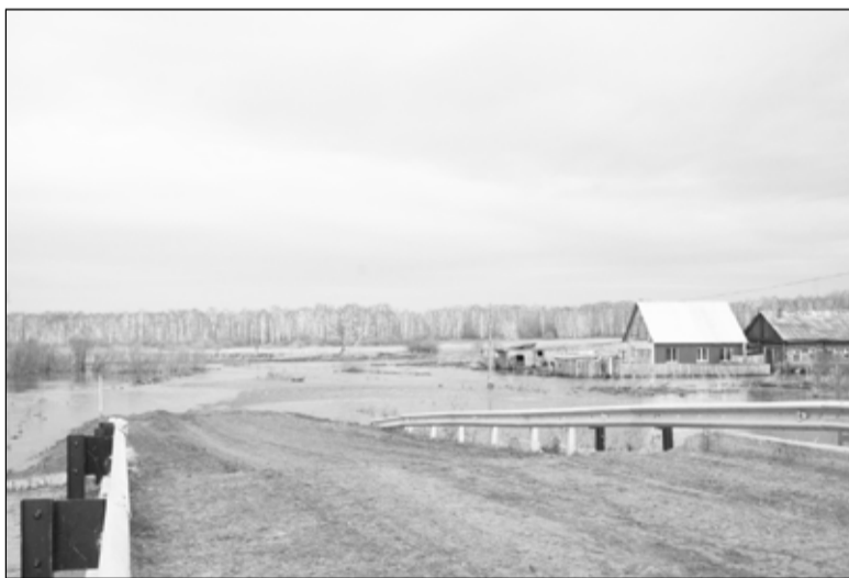
Дорога к улице Заречной и ферме ПСХК «Болдыревский» под водой
