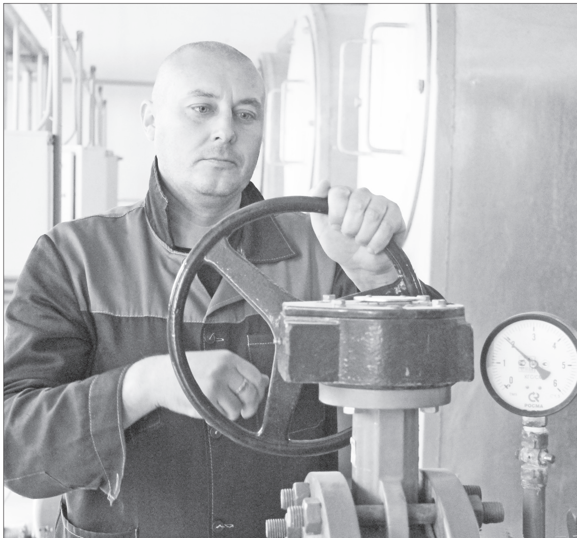
Оператор газовой котельной «Центральная» Андрей Юрлов проверяет давление в системе. Сети запитаны, ждём тепла. / ФОТО АВТОРА.
