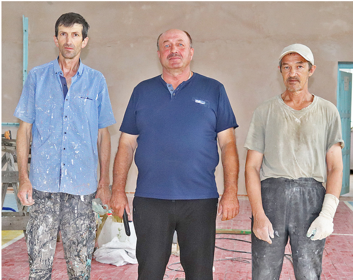
Под руководством Юрия Бушневского (в центре) делают ремонт в спортивном зале Новоселезнёвской школы штукатур Феруддин Аликберов (слева) и отделочник Александр Бондаренко
