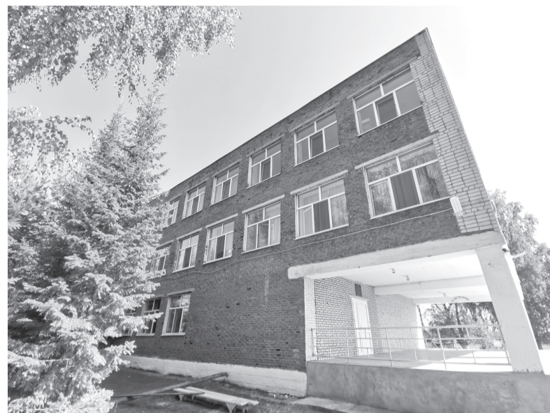
В Левобережье произведён капитальный ремонт школы
