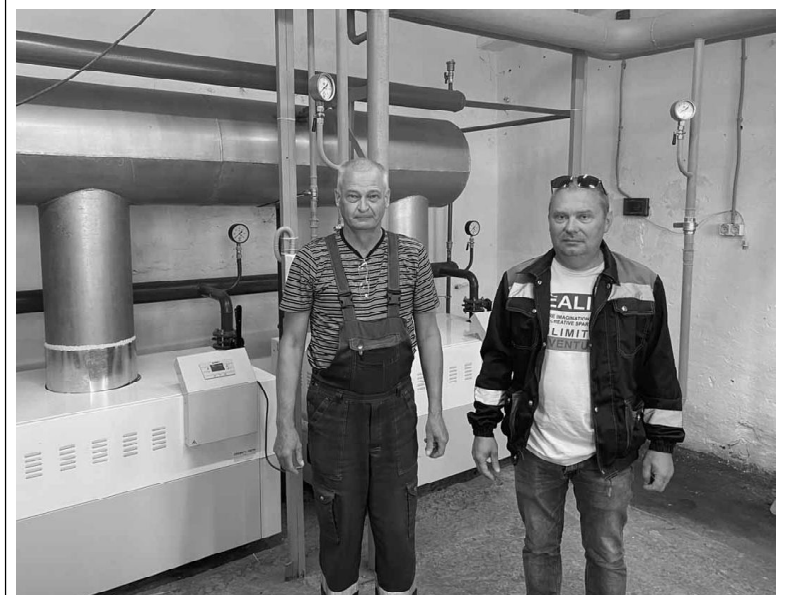
Слесарь аварийно-диспетчерской службы Михаил Коморников и инженер ООО «Ромист» Максим Авдюков принимали непосредственное участие в ремонте котельной
