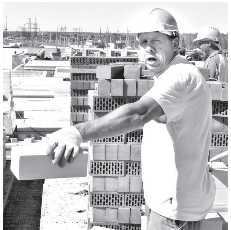
• Каменщик Андрей Седачёв – строитель со стажем. Раньше работал в «Загросе», а сейчас в ООО «Град», которое строит пятиэтажку на улице Энергетиков в городе.
