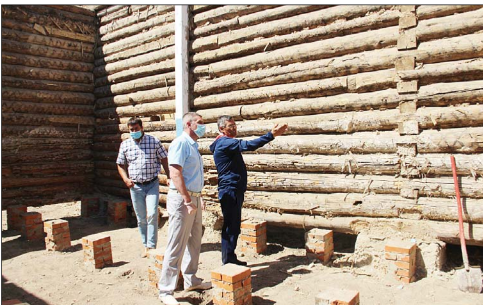
• В 2021 году отремонтировано два сельских Дома культуры.
