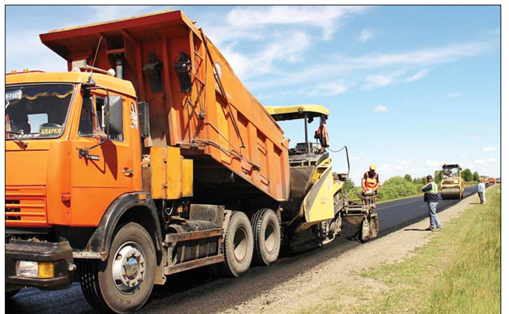
• Укладка нового асфальта на автодороге Аромашево – Гольшманово.
