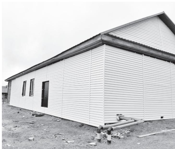
Закончены наружные работы: утеплены и обшиты стены здания, но работы на этом не заканчиваются, еще предстоит замена пола, переоборудование сцены, освещения, мест для хранения костюмов и внутренние косметические работы.
