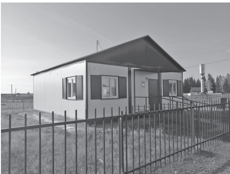
Новый модульный ФАП в д. Юрмы
