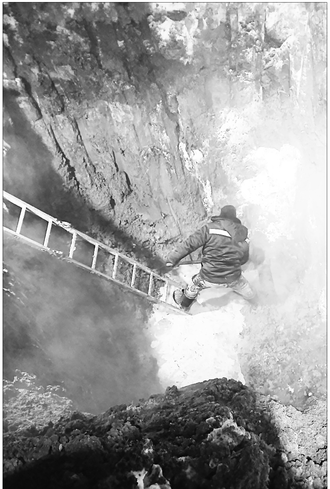
Этот маленький человек в огромной яме – слесарь аварийно-восстановительных работ Виктор Леонов. Потребовалось 12 часов на морозе, чтобы устранить крупную аварию уличного водопровода. / ФОТО АВТОРА.
