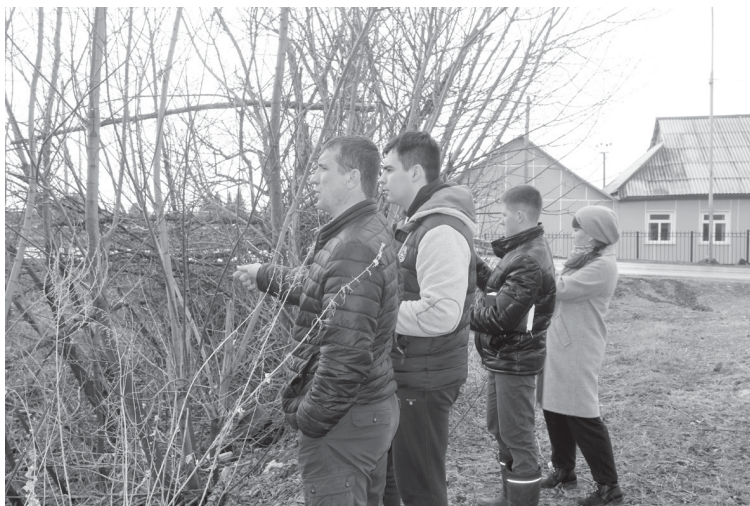
Следующий этап – осмотр участка дамбы, начинающегося на улице Дзержинского
