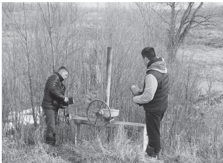
Проверка состояния водозащитного шлюза на восточной части ярковской дамбы
