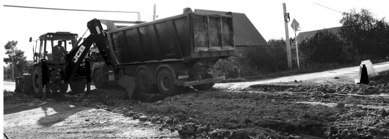
Идёт ремонт на участке дороги на улице Энгельса в посёлке Голышманово
