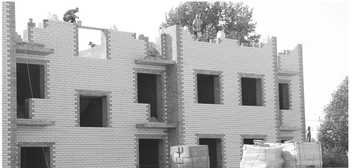
На строительной площадке ИП Владимира Круглика в переулке Майском
