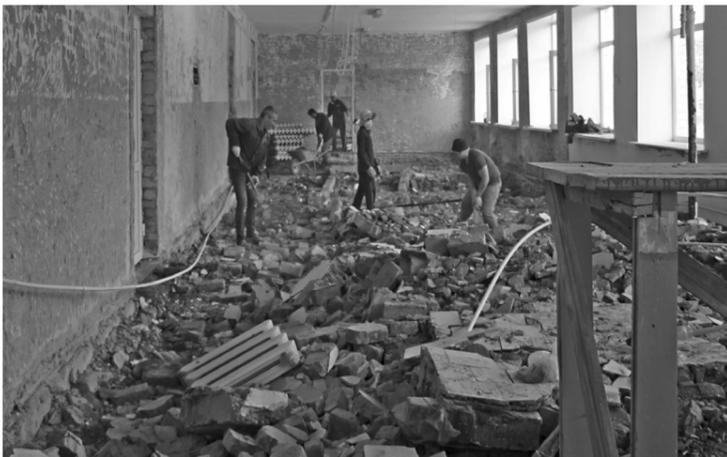
Капремонт начали с демонтажных работ: сняли старую штукатурку, вскрыли полы, снесли перегородки
