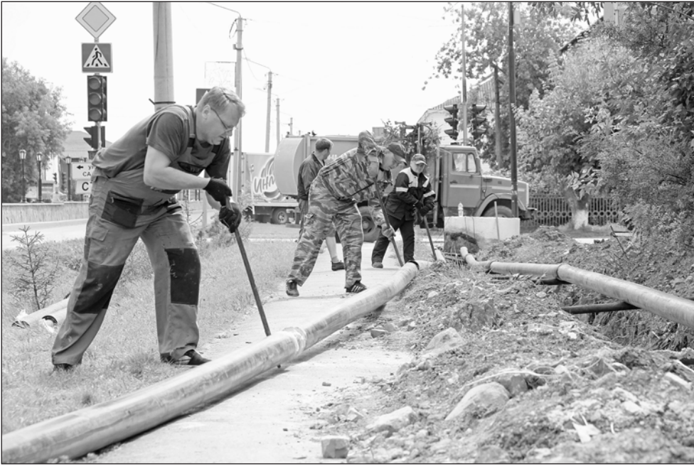
Ремонт теплотрассы на улице Ленина
