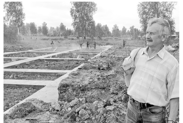
Фундамент для многоквартирного дома – очень сложное дело, ещё предстоит выложить в три ряда блоки, прежде, чем выйдут на цоколь. Глава поселения А.Субботин контролирует процесс.
