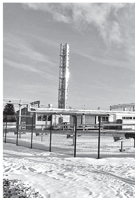
• Газовая котельная на улице Вокзальной в городе обеспечивает теплом 114 объектов центральной части Заводоуковска.
