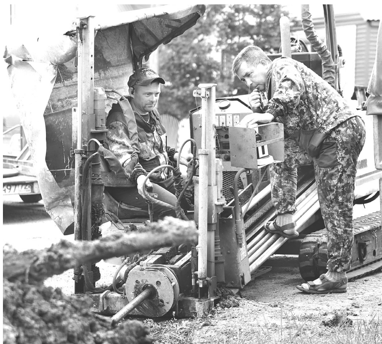
Евгений Дюрягин (на фото слева) управляет навигатором, а руководит процессом Игорь Фёдоров. Прокладывают водопровод в частный дом по улице Комсомольской
