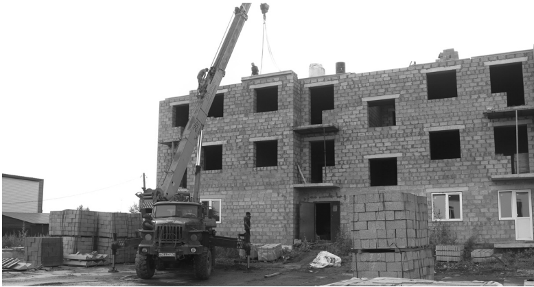
На строительной площадке ООО «Голышмановоагропромстрой» полным ходом идут работы
