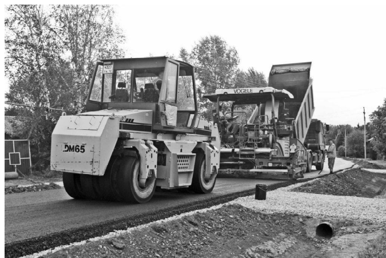
➤ Укладка второго слоя асфальта
