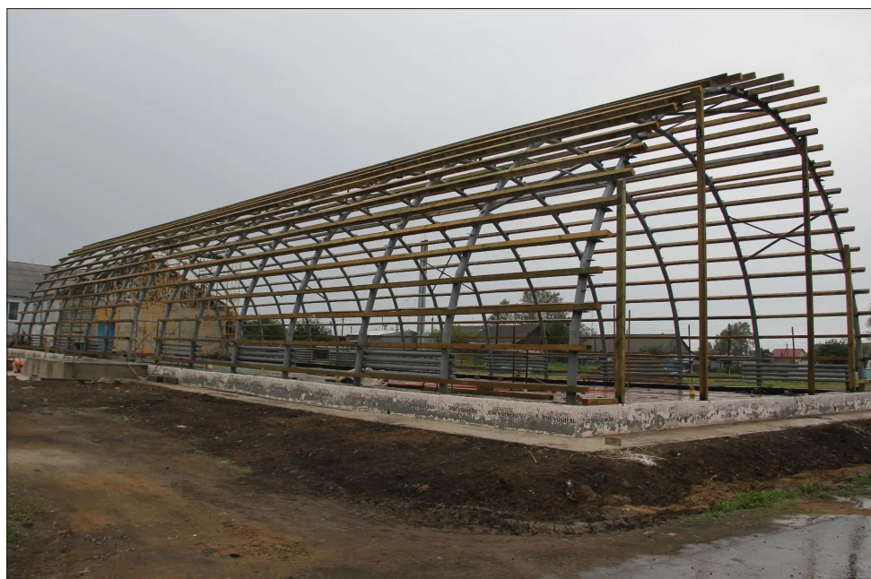
• Большие ремонтные работы ведутся в помещении спортзала Юрминского филиала.
