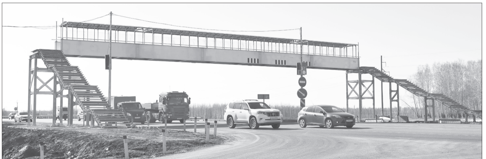
В начале октября на беркутском перекрёстке демонтировали светофор и разделили встречные потоки отбойником /ФОТО ИЗ АРХИВА РЕДАКЦИИ
