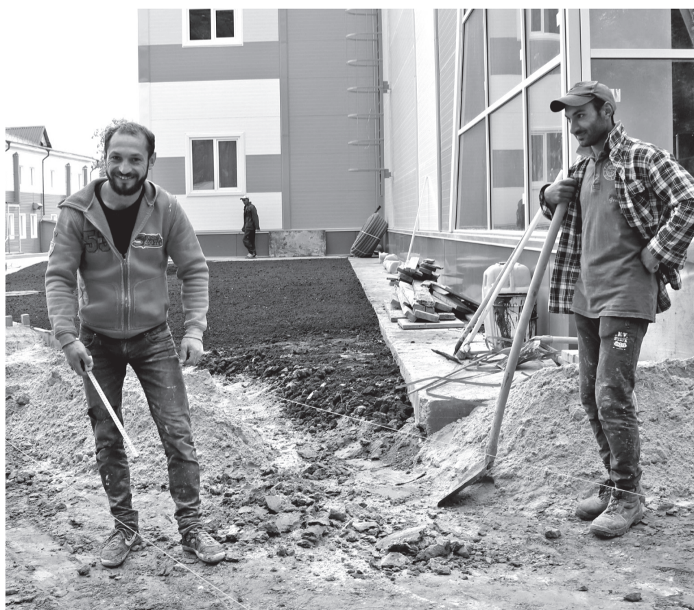
• Строительная бригада «Титан-профиль» завершает укладку брусчатки по периметру здания бассейна, который строится в городе на улице Ермака.
