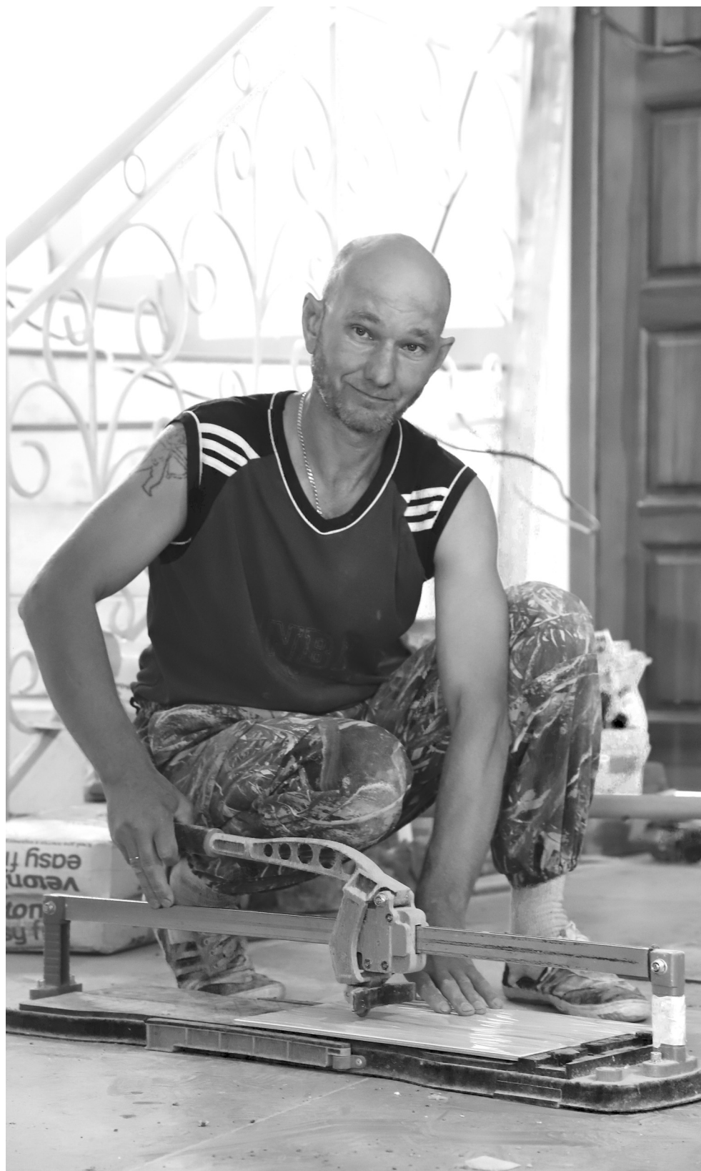
Профессия штукатур-плиточника сродни ювелирной. Сергей Ветошкин уверенно гранит керамику тяжёлым плиткорезом
