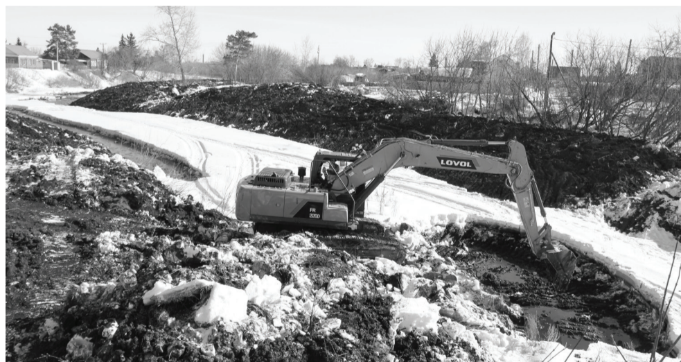
В план подготовки к весеннему паводку включены мероприятия по расчистке русел малых рек. // Фото автора.
