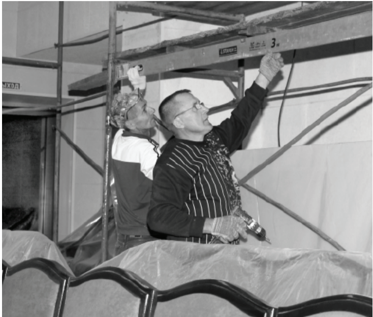
Строители ведут реконструкцию кинобудки.
