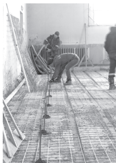
Работы идут в большом спортзале
