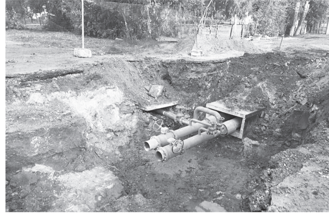
На лето запланирован ремонт системы теплоснабжения
