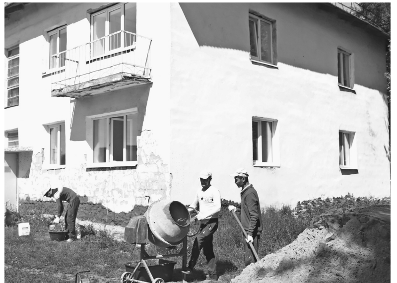
Ремонт здания амбулатории строители начали с оштукатуривания фасада
