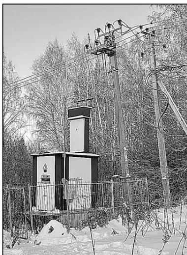
разгрузки уже действующей ТП в переулке Новом специалисты также заменили трансформатор мощностью 400 кВА. После завершения работ были проведены замеры напряжения у потребителей, которые подтвердили, что показатели качества электроэнергии по данным улицам соответствуют ГОСТу.
