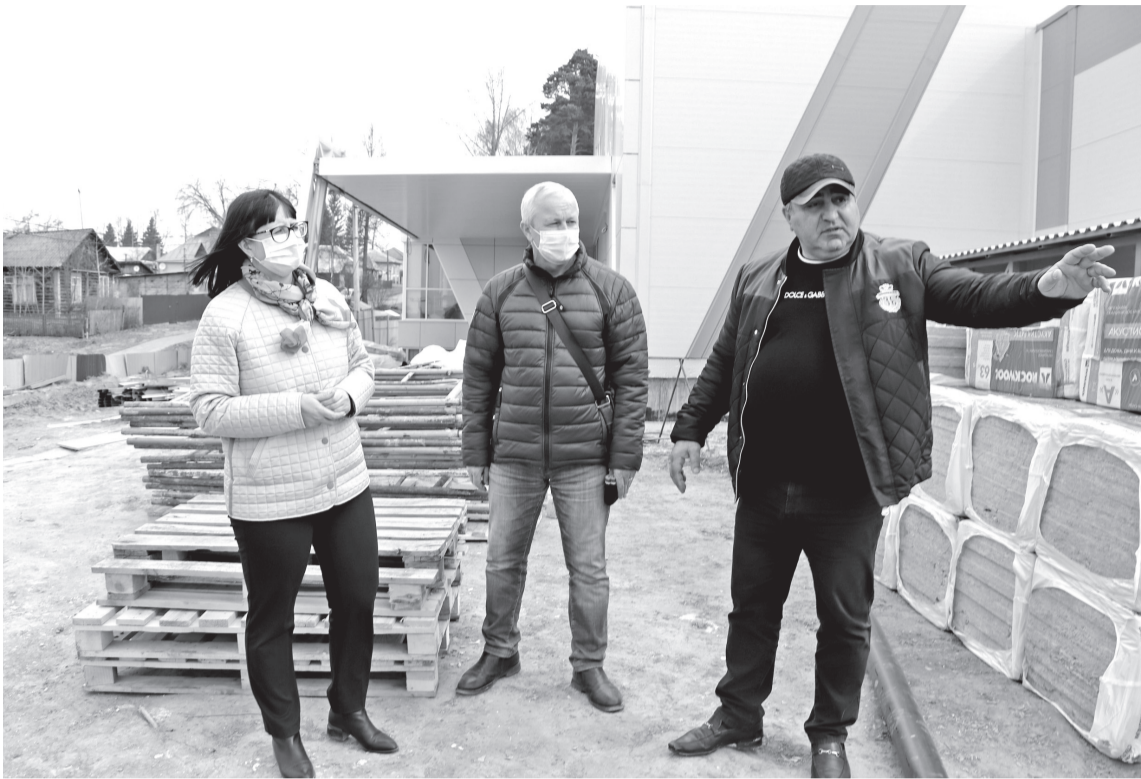
• Весна 2021 года. Строительство бассейна в Заводоуковске. На возведении объектов в рамках проекта по созданию комфортной городской среды главу городского округа Светлану Касенову можно видеть часто. Она предпочитает сама контролировать ход строительных работ.
