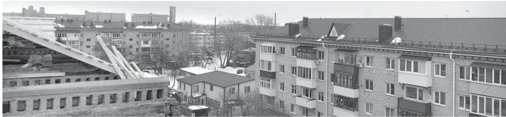
При ремонте кровель плоские покрытия, плохо приспособленные для нашего климата, заменяют скатными. Подрядные организации монтируют стропильные системы на домах № 15а и № 20 на ул. Рокоссовского. //Фото департамента ЖКХ Тюменской области.
