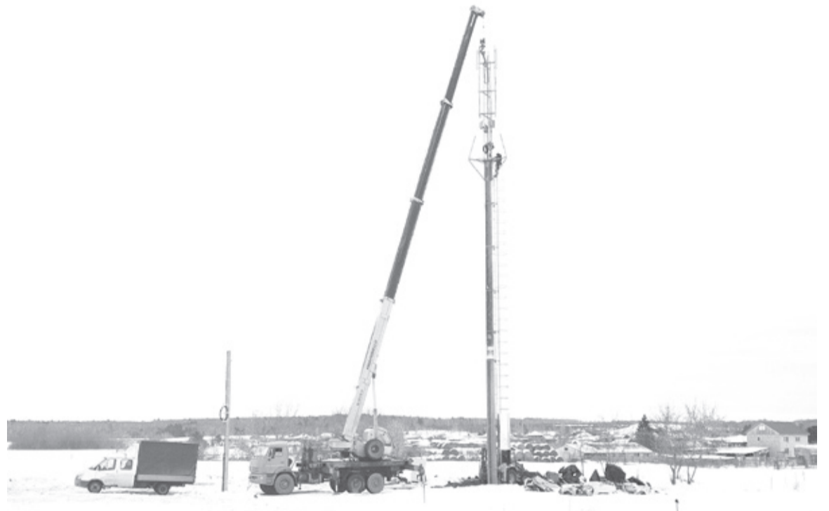
|| Установка вышки сотовой связи. Фото из архива администрации поселения
