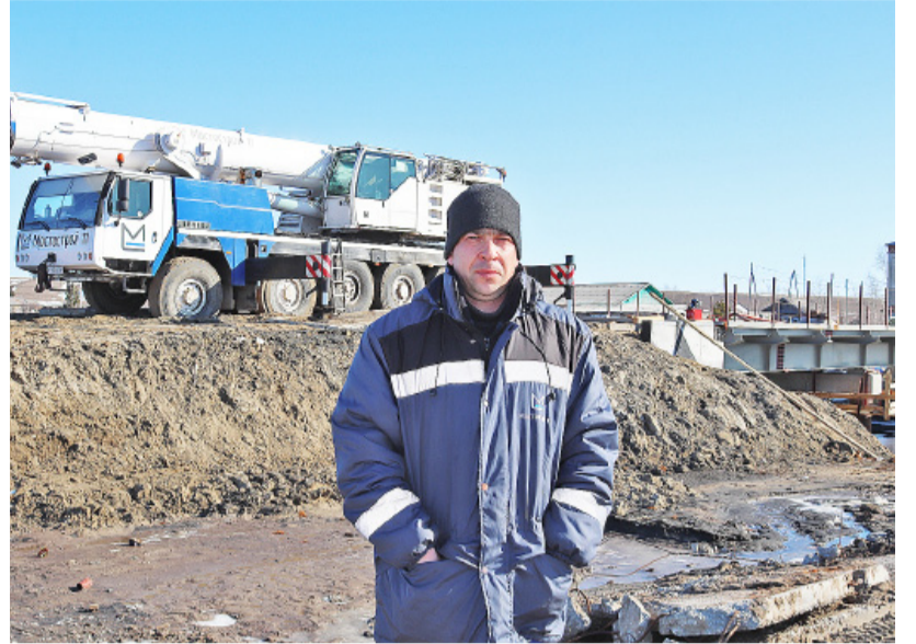
Крановщик АО «Мостострой-11» Виталий Анисимов добросовестно выполнил свою работу
